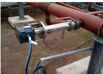
WMS Stabsensoren für Ex geschützte Einsatzbedingungen.
