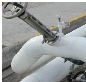
WMS Stabsensoren für Ex geschützte Einsatzbedingungen.
