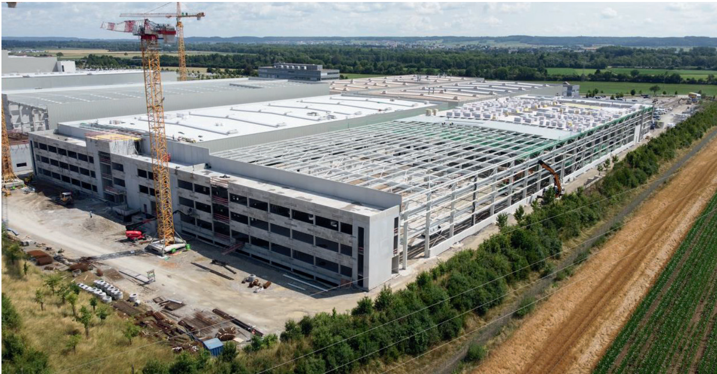
Abbildung 9: Umsetzungsstand des Neubaus im Sommer 2023: Auf 46.000 qm entstehen drei neue Hallen für mechanische Fertigung, Logistik und weitere Bereiche sowie ein zusätzliches Verwaltungsgebäude. Im Hintergrund sind die beiden bereits seit 2017 genutzten Gebäude für Montage, Logistik, Lackierung und Verwaltung zu sehen.
