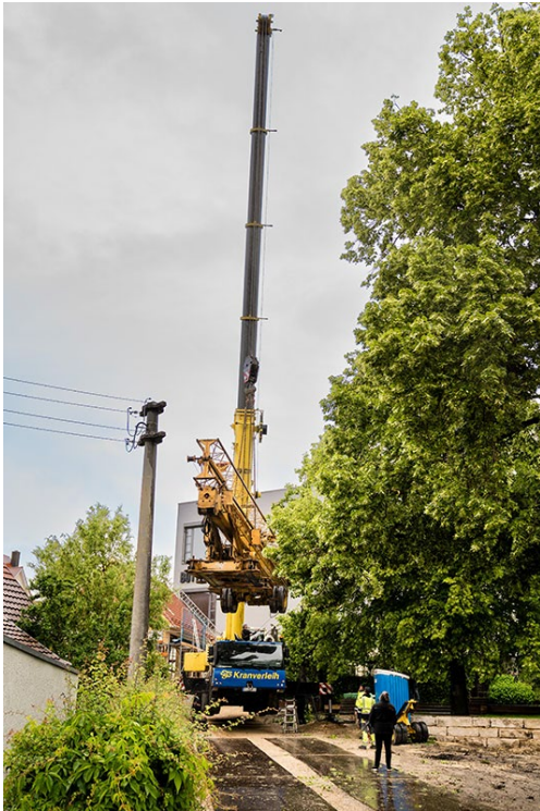
liebherr-ltm1130-5.1-esb-berg-02.jpg Wenig Platz – das Abstützen des Mobilkrans war eine Herausforderung.
