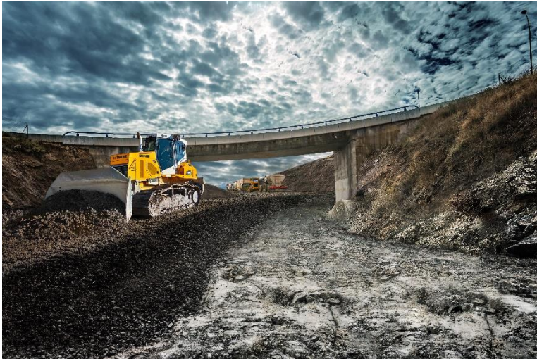
liebherr-pr726-straßenbau.jpg Die leistungsstarke PR 726 beim Straßenbau.
