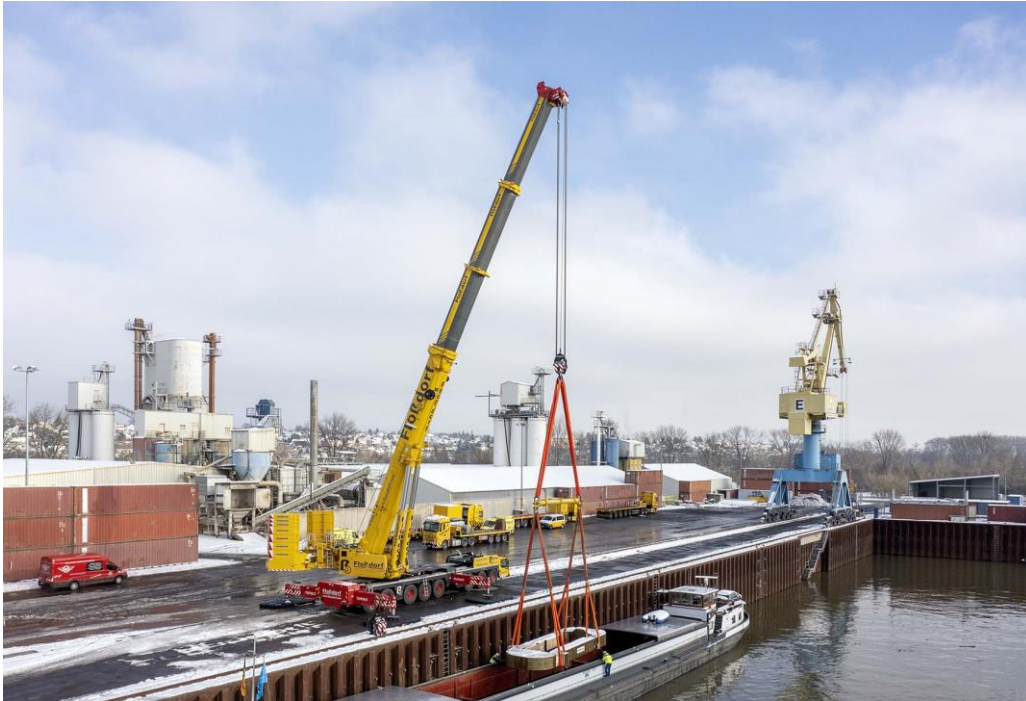
liebherr-ltm1650-8-1-flossdorf-1.jpg Der neue LTM 1650-8.1 von Floßdorf verlädt beim ersten Einsatz schwere Maschinenteile am Rheinhafen Andernach.
