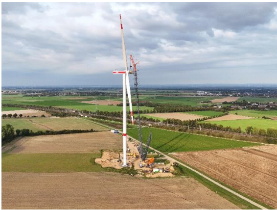
liebherr-lr1000-verschoor-05.jpg Bald drehen sie sich im Wind: Der LR 11000 bringt die Rotorblätter an.
