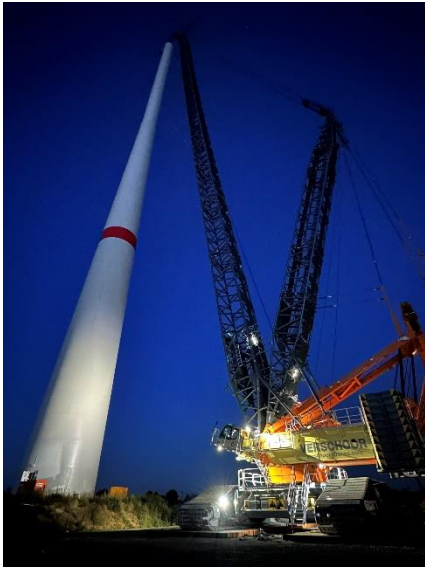
liebherr-lr1000-verschoor-07.jpg Bauteil für Bauteil wird die Windturbine errichtet.
