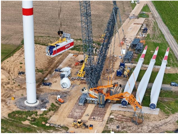
liebherr-lr1000-verschoor-04.jpg Der LR 11000 hebt die Gondel auf en Turm der Windturbine.
