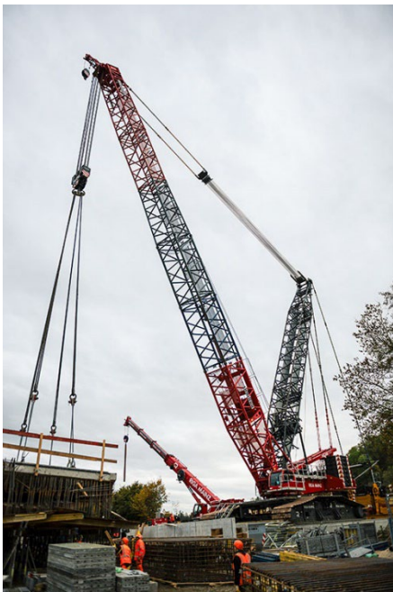
liebherr-lr1750-2-riga-mainz-02.jpg Für einen stabilen Stand des Raupenkrans war eigens eine zwei Meter dicke, 18 x 18 Meter große Betonplatte gebaut worden.
