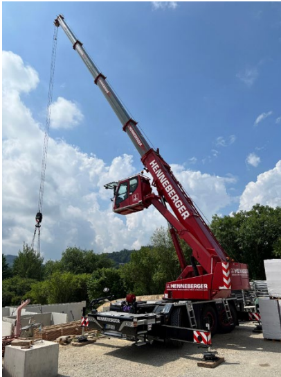
liebherr-ltc1050-3-1-henneberger-ilmenau.jpg Der LTC 1050-3.1 setzt Wandelemente in Ilmenau.
