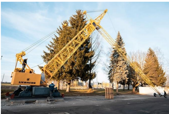
liebherr-tdk-30A-35-Aufrichten-high-res.jpg Liebherr 30A/35 устанавливают в Центре б/у техники и аренды Liebherr в городе Бад Вальдзее.
