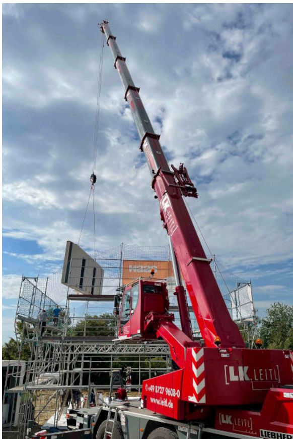
liebherr-ltc1050-3-1-leitl-3.jpg Optimale Sicht auf die Montagesituation mit der Liftkabine.
