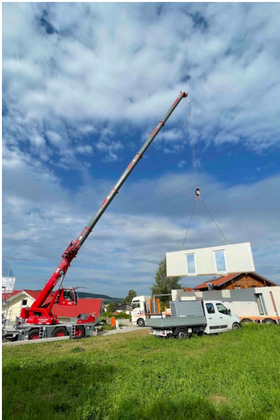
liebherr-ltc1050-3-1-leitl-2.jpg Leitl setzt den LTC 1050-3.1 beim Ersteinatz zur Montage eines Fertighauses ein.
