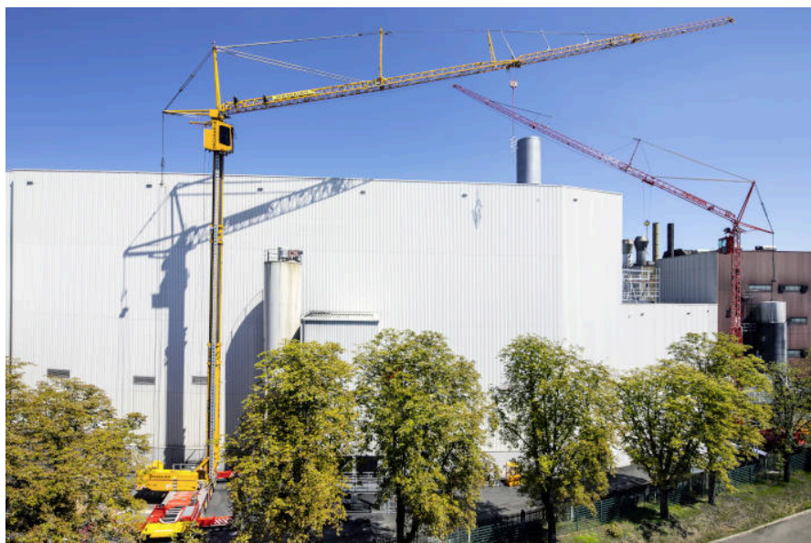
liebherr-mk88-mk140.jpg MK88 und MK 140 im Industrie-Montage-Einsatz.
