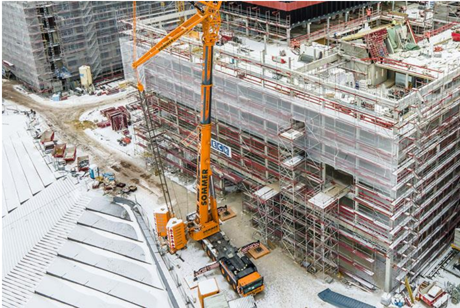
liebherr-ltm1450-8-1-sommer-04.jpg Der VarioBallast® des LTM 1450-8.1 ist auf der engen Baustelle Gold wert.
