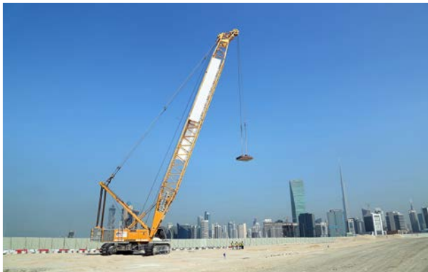
liebherr-o.rentals-dubai.jpg Bodenverdichtung in Dubai.
