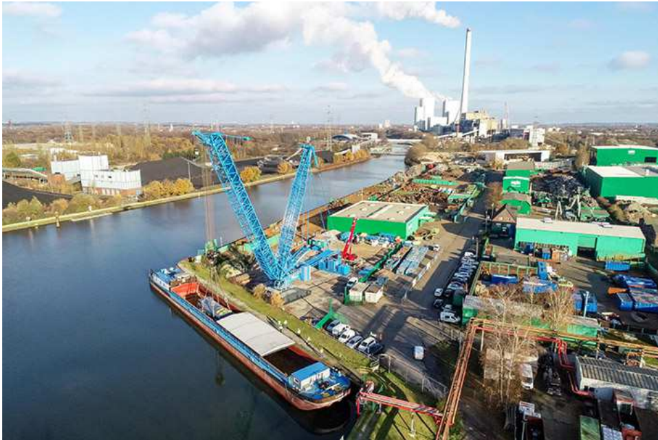
liebherr-felbermayr-lr11000-photo1.jpg Bereit zum Hub: Der Schwebeballast ist aufgestapelt und die Last angeschlagen. Im Hintergrund ist das Gas-und-Dampfturbinen-Kraftwerk mit Erweiterungsbau zu sehen.
