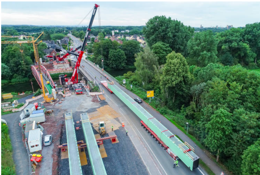
liebherr-schaes-itm1500-8.1-motive1.jpg SPMTs fahren die schweren Träger auf die 70 Jahre alte Lippebrücke.
