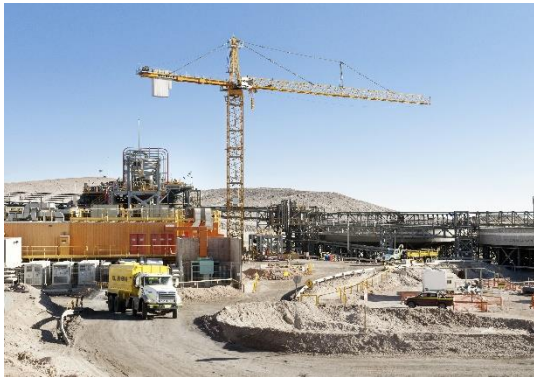
Guindaste de torre 1000 EC-H na mina de Centinela, no Chile
