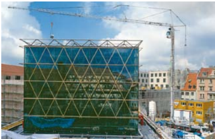
Maximale Reichweite dank horizontalem Lastweg.
