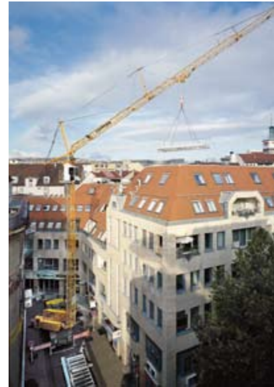
Beengter Innenstadt-Einsatz. 15°-, 30°- und 45°-Auslegersteilstellungen serienmäßig.
