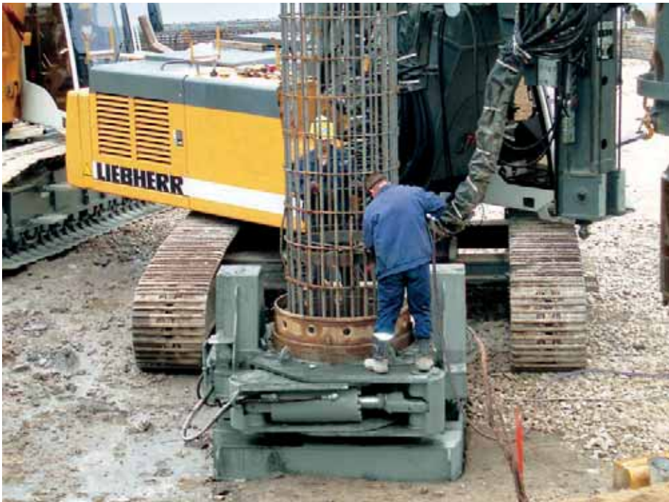
VRM KL im Einsatz
