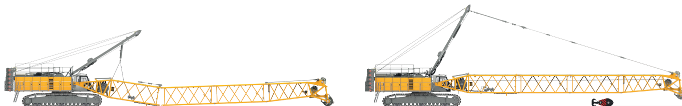
Montagem da lança
