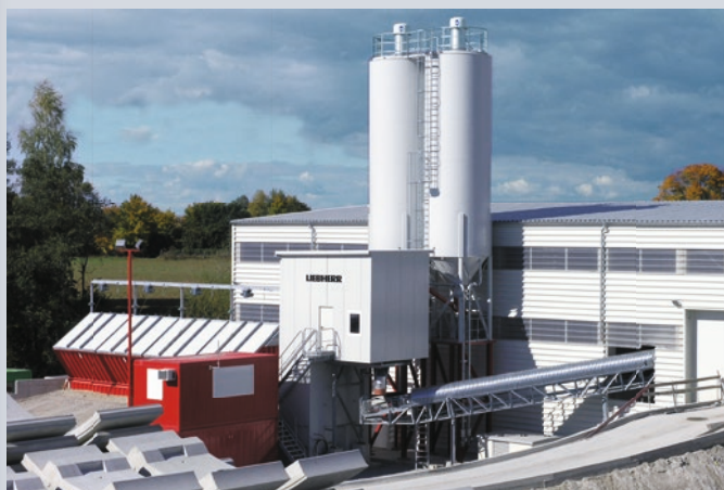
Сompactmix 1.0 подключен напрямую к производству ЖБИ изделий.
