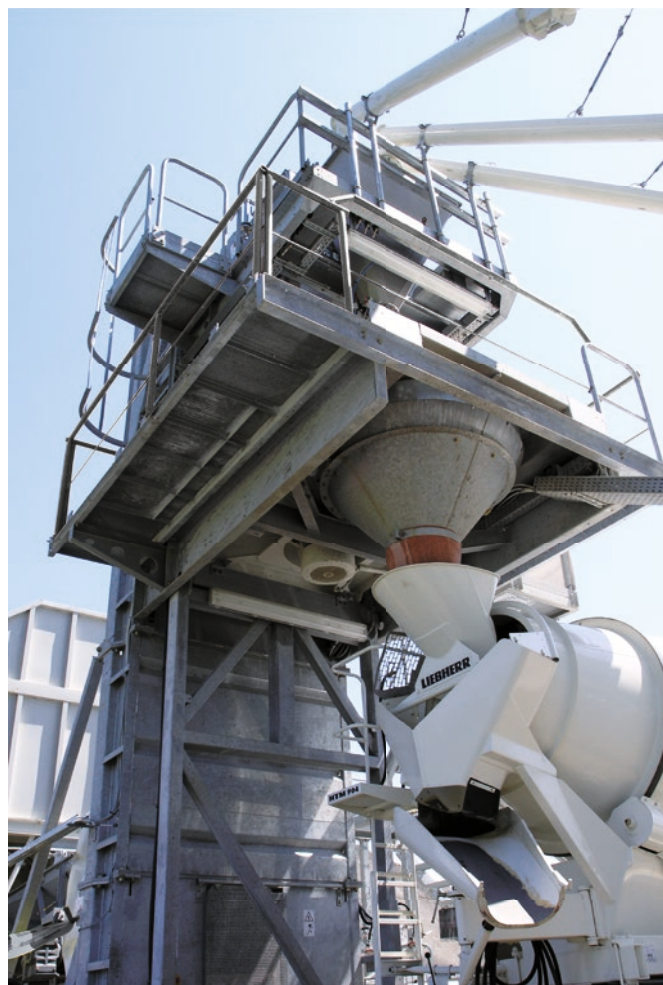
Большое пространство под площадкой смесителя.
