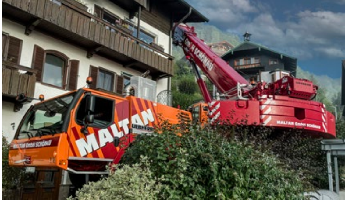
Enge Baustellen erfordern zentimeter- genaues Rangieren.
