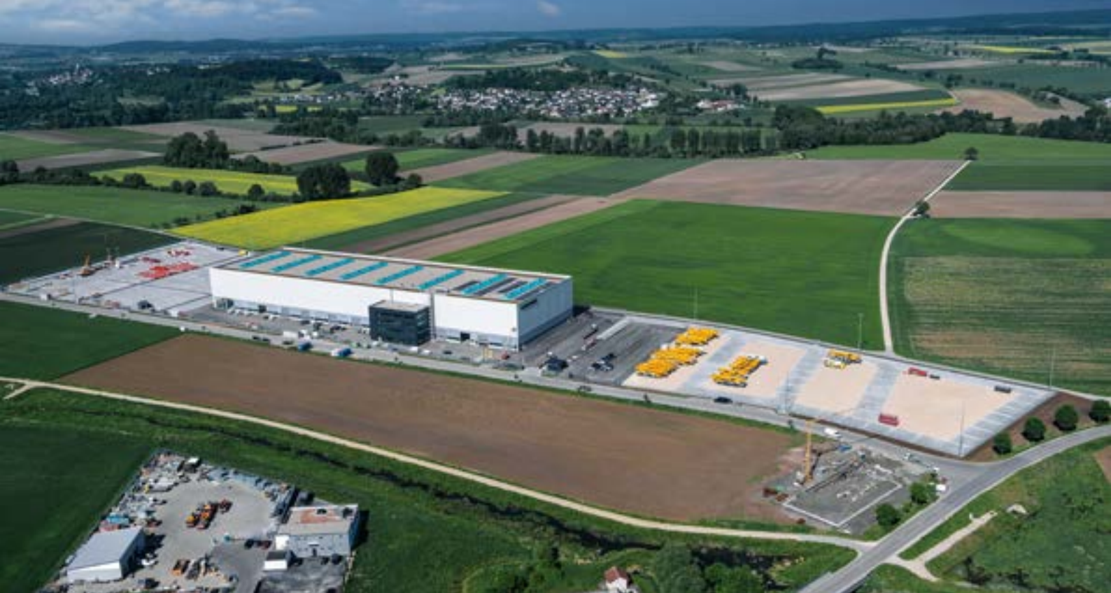
Das Reparaturzentrum am Standort Ehingen-Berg.
