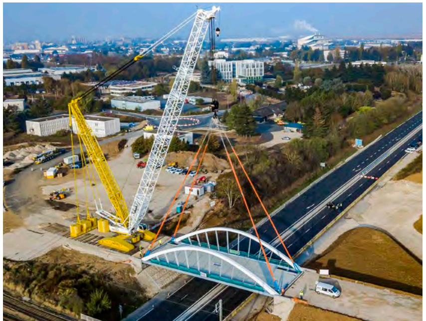
Der französische Kranverleih Mediaco setzt seinen gebrauchten Liebherr-Raupenkran LR 1600/2 beim Brückenbau in Blois, Frankreich, ein.
