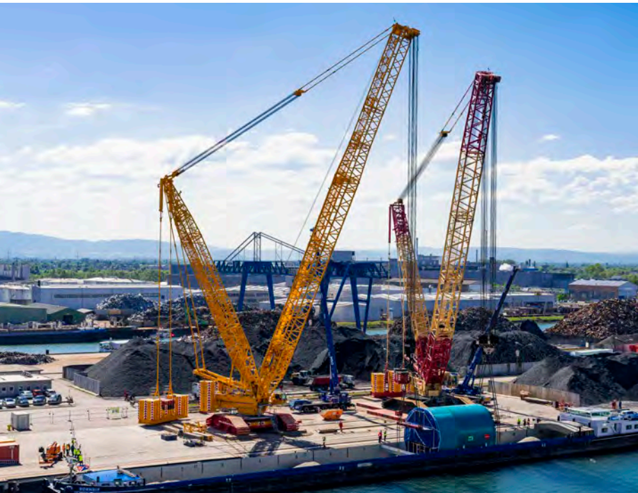
Mission erfüllt: die Tunnelbohrmaschine ist auf dem 110 Meter langen Frachtschiff verstaut. Fünf Tage wird es mit seiner Last für die Strecke nach Rotterdam benötigen.
