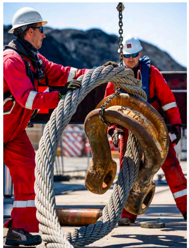
Große Kaliber: überdimensionale Schäkeln und gigantische Stahlseile fordern die Männer beim Handling mit den Anschlagmitteln.
