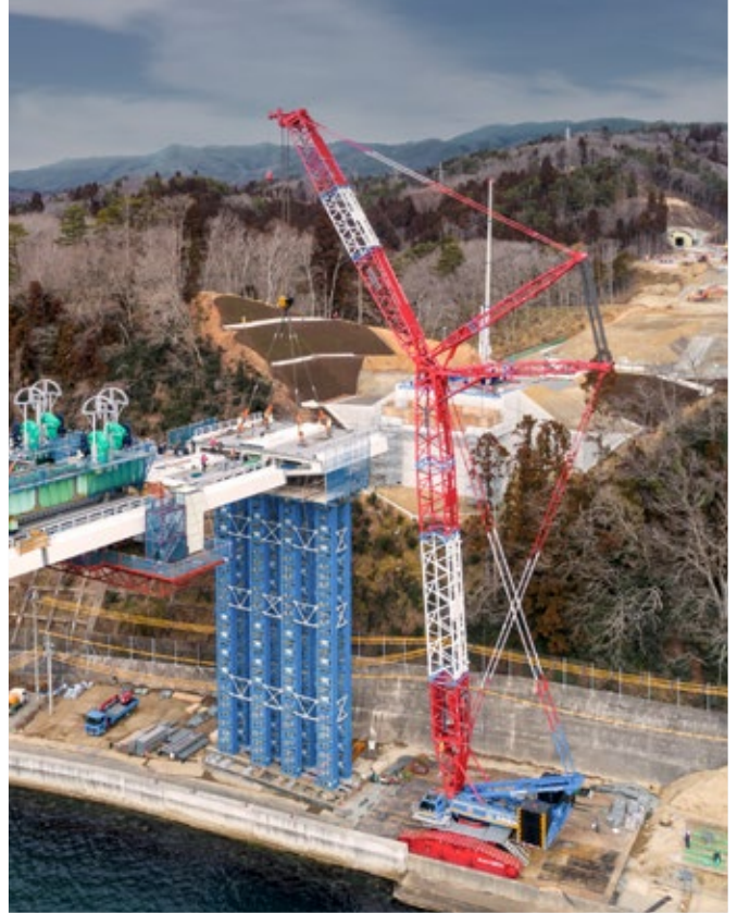
Ein LR 1750/2 beim Brückenbau in Japan
