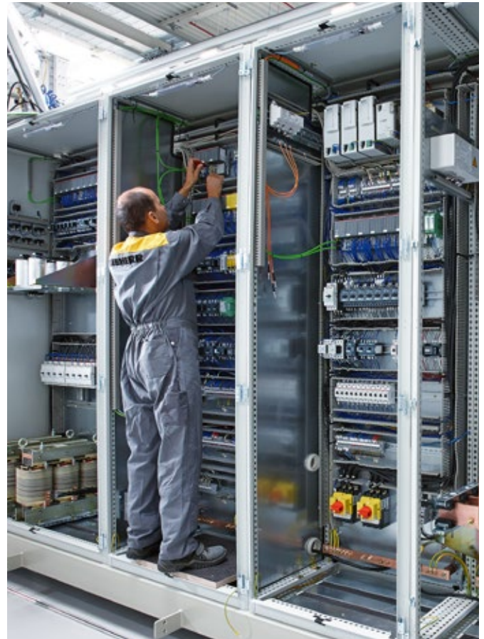
Installation von Schaltanlagen für Containerkrane
