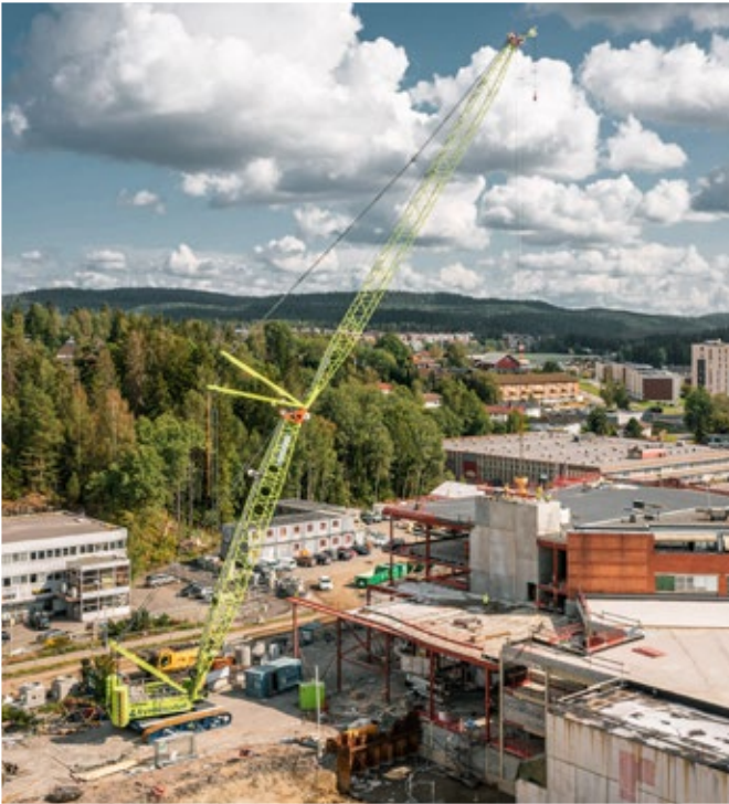
Der batteriebetriebene Raupenkran LR 1250.1 unplugged bei Hebearbeiten in Oslo (Norwegen)
