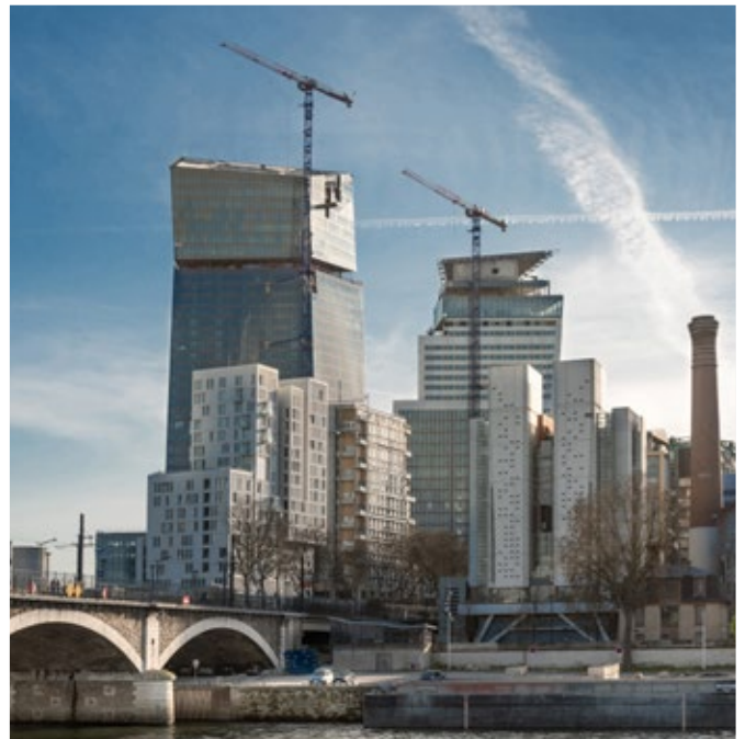
Zwillingstürme: EC-B-Krane im Einsatz bei Tours Duo in Paris (Frankreich)
