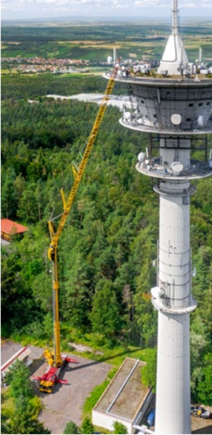
Der MK 140 im Wipmodus beim Austausch der Antennentechnik eines Fernmeldeturms
