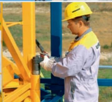
Schnelles Anziehen und Lösen der Schrauben mit dem Hydraulikscharber.
