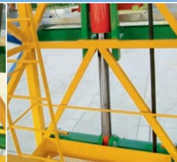
Die Kolbenstange der Presse (rot) fährt aus und drückt das komplette Kranoberteil nach oben.
