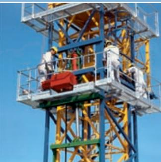
Die Klettereinrichtung mit Führungsstück, Klettertraverse und Hydraulikanlage.
