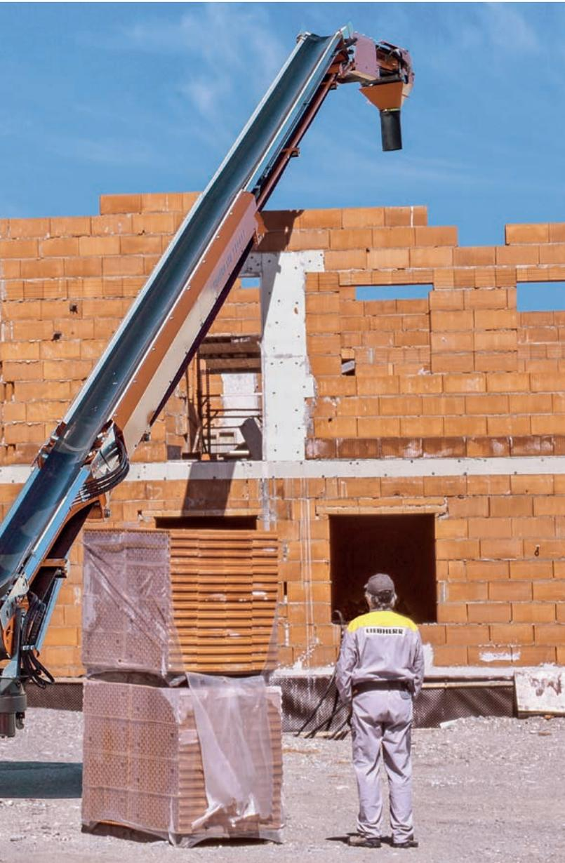
Das Liebherr-Förderband LTB ist in wenigen Minuten einsatzbereit. Dies wirkt sich positiv auf die Wirtschaftlichkeit aus. Durch die geschlossene Bauweise und die Verkleidungselemente ist das Band einfach und schnell zu reinigen.
