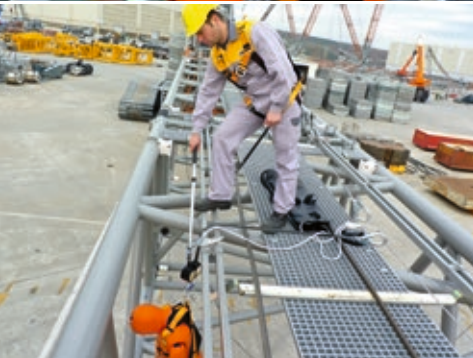
Einhängen des Karabiners mit Hilfe einer Teleskopstange
